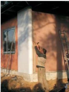
pierwszy element styropia nowy o wymiarach 120 x 300 x 15,5 cm został zamontowany na elewacji budynku. Należy pamiętać, że zgodnie z życzeniem inwestora jest zaokrąglony.
