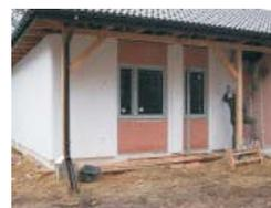
montaż elementów ocieplających między oknami. Wypełnienie przestrzeni między oknami nastąpi w końcowym etapie prac wraz z montażem architektonicznych elementów dekoracyjnych.
