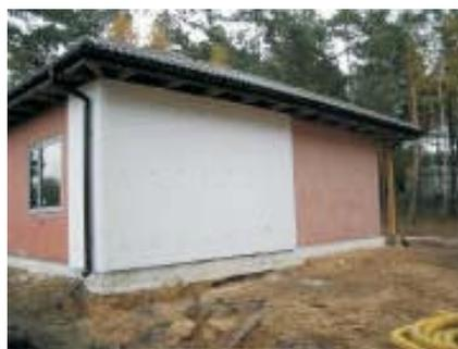
wycięcie i zamontowanie 5 płyt o łącznej powierzchni 18 m<sup>2</sup> zajęło ekipie złożonej z dwóch pracowników zaledwie 45 minut.
