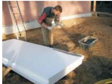
każdy element przed montażem pokrywany jest na krawędziach cienką warstwą kleju. Płyta montowana jest do elewacji 6 plastikowymi kołkami.
