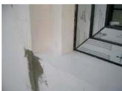
montaż elementów podokiennych. Dzięki dużej precyzji wycinania na ploterze miejsca łączenia płyt pozbawione są mostków termicznych..
